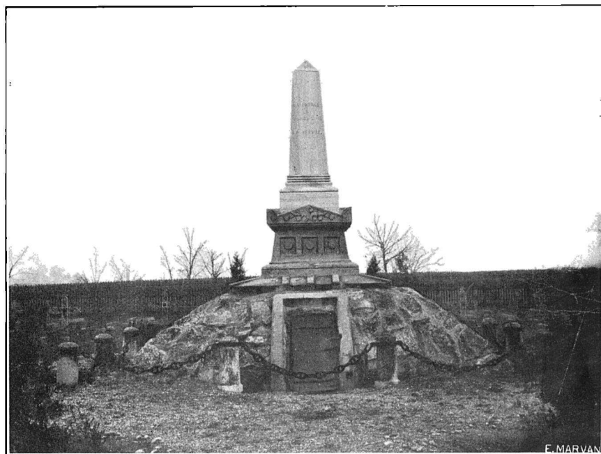
MONUMENTUL FRANCEZ AL EROILOR CAZUȚI ÎN CAMPANIA DIN 1854 (Aflat în cimitirul orașului)
