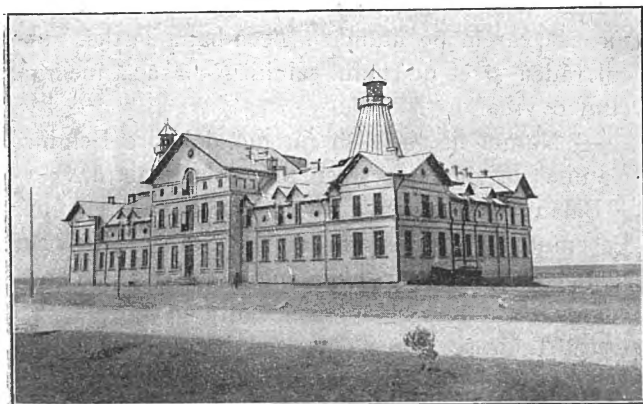
Pavilionul băilor «Movilă», de pe malul lacului.
